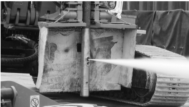
Bild 2. Hochdruckstrahl am Austritt des Düsenstrahlgestänges.
