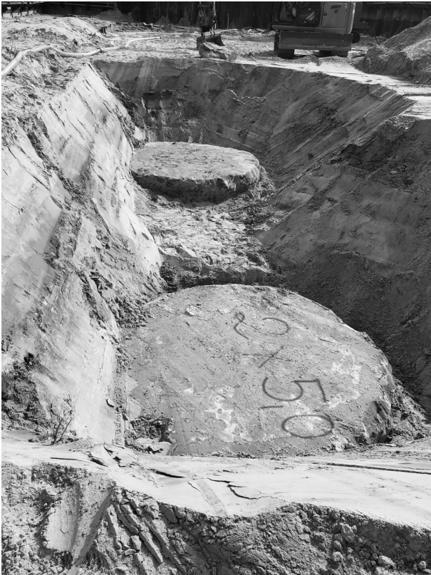
Bild 3. Freigelegte Probesäulen im Düsenstrahlverfahren.
