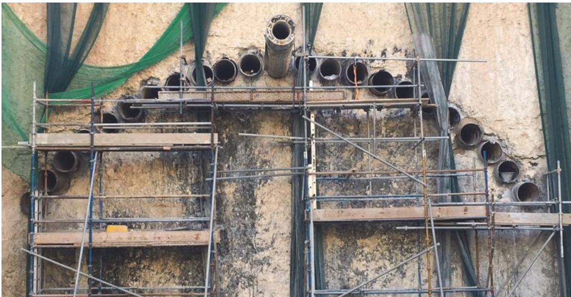
Abb. 3: Bohrungen für Rohrschirm im Tunnelbau (Bohrtec Gesellschaft für Bohrentechnologie mbH, o.J.)
