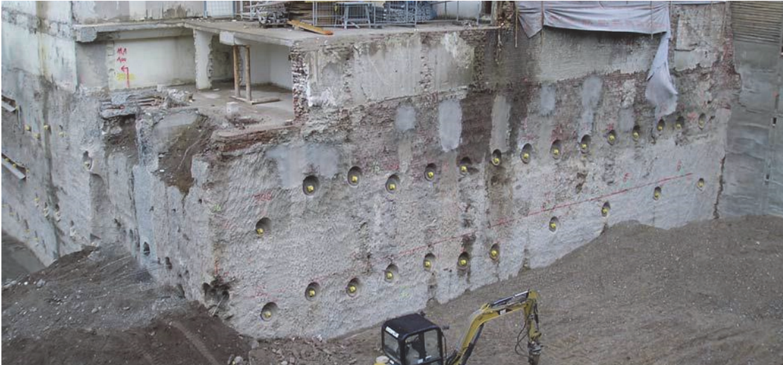
Abb. 1: Kreuzende Anker an Baugrubenecke (Knitsch & Pandrea, 2008)
