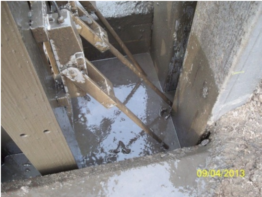
Abb. 14: Messarme bei der Vermessung einer Stahlflachfuge
