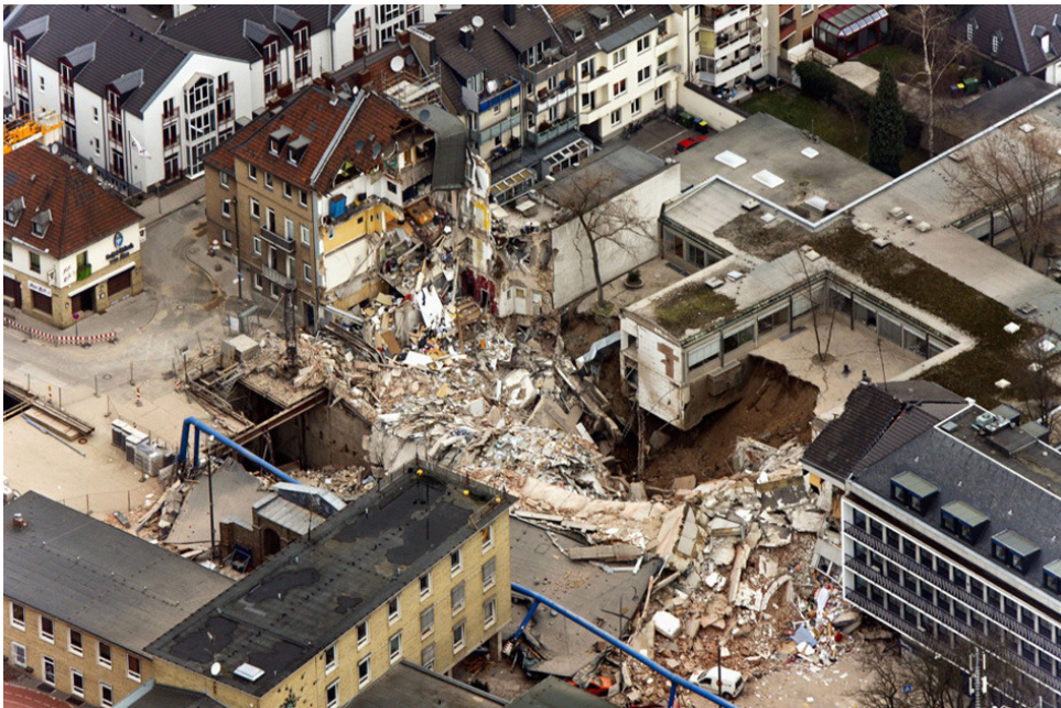
Abb 1: Luftbild nach dem Einsturz
