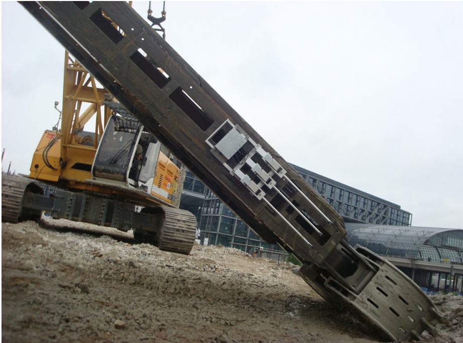
Abb. 14: Der Fugeninspektor Montiert am Schlitzwandgreifer
