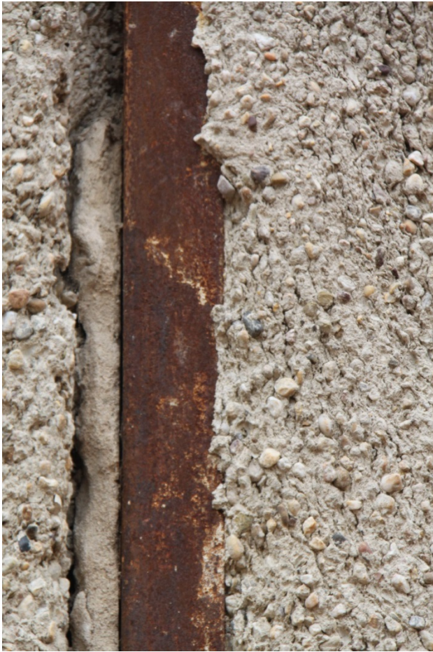
Abb. 8: Umlaufbeton in einer Schlitzwandfuge
